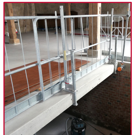
Quer zum Deckenrand montierte System-Geländerzwinge mit dem System-Gittergeländer.
